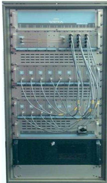
photo1 : vue de face du rack en configuration 12 canaux RX
